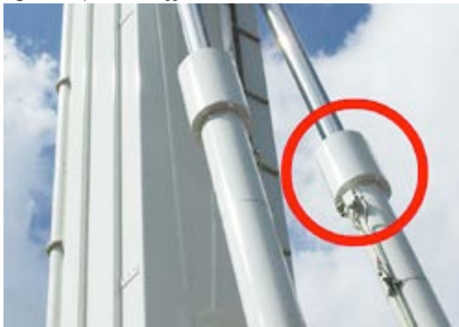
Figura 7. Dispositivi bloccaggi KRG montati direttamente sulle teste dei cilindri
